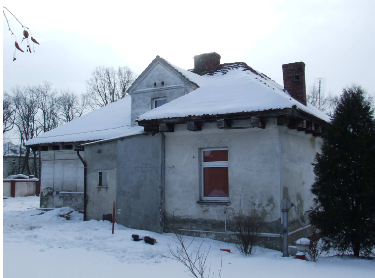
Rys. Widok budynku od strony północno zachodniej
