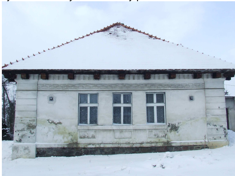
Rys. Widok budynku od strony wschodniej
