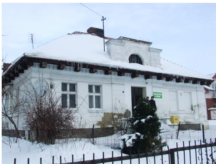
Rys. Widok budynku od strony południowo zachodniej
