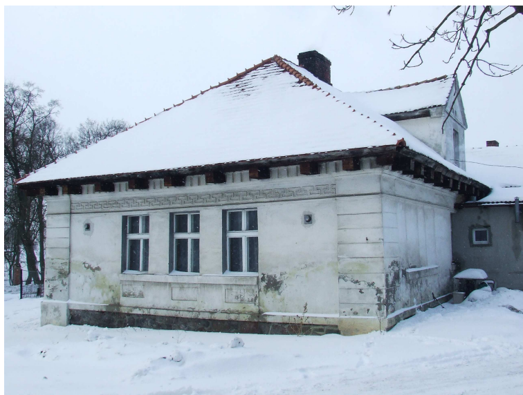
Rys. Widok budynku od strony północno wschodniej
