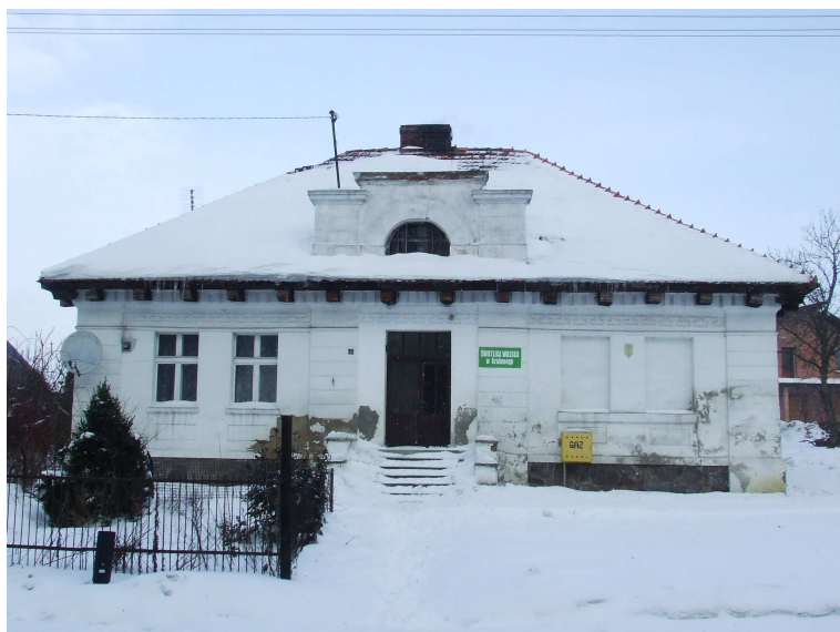
Rys. Widok budynku od strony południowej
