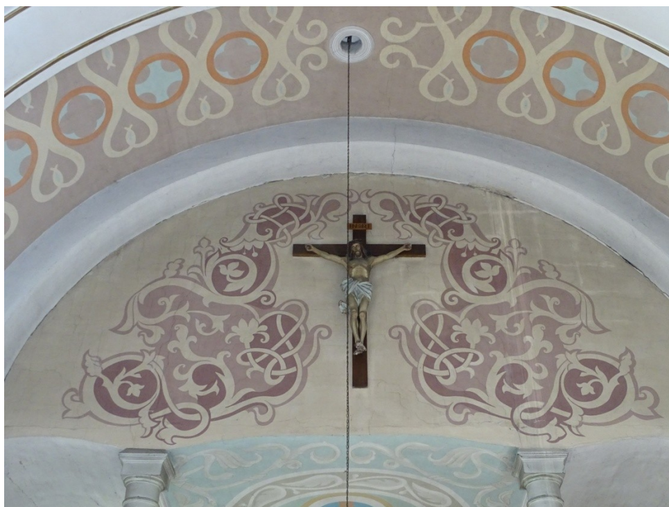
Fot. 48 Widok na wschodnią część nawy głównej
